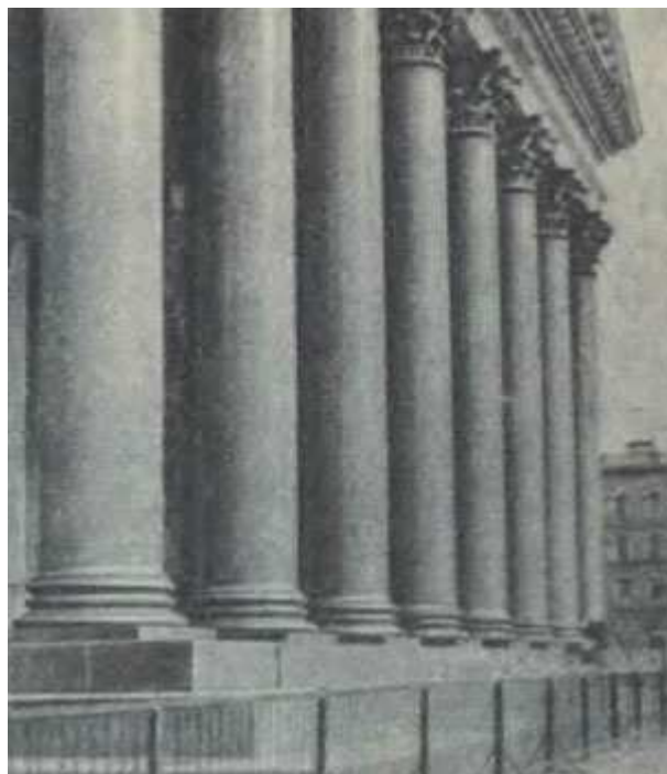
Рис. 50. Грандиозные цельные колонны Исаакиевского собора из Выборгского гранита
