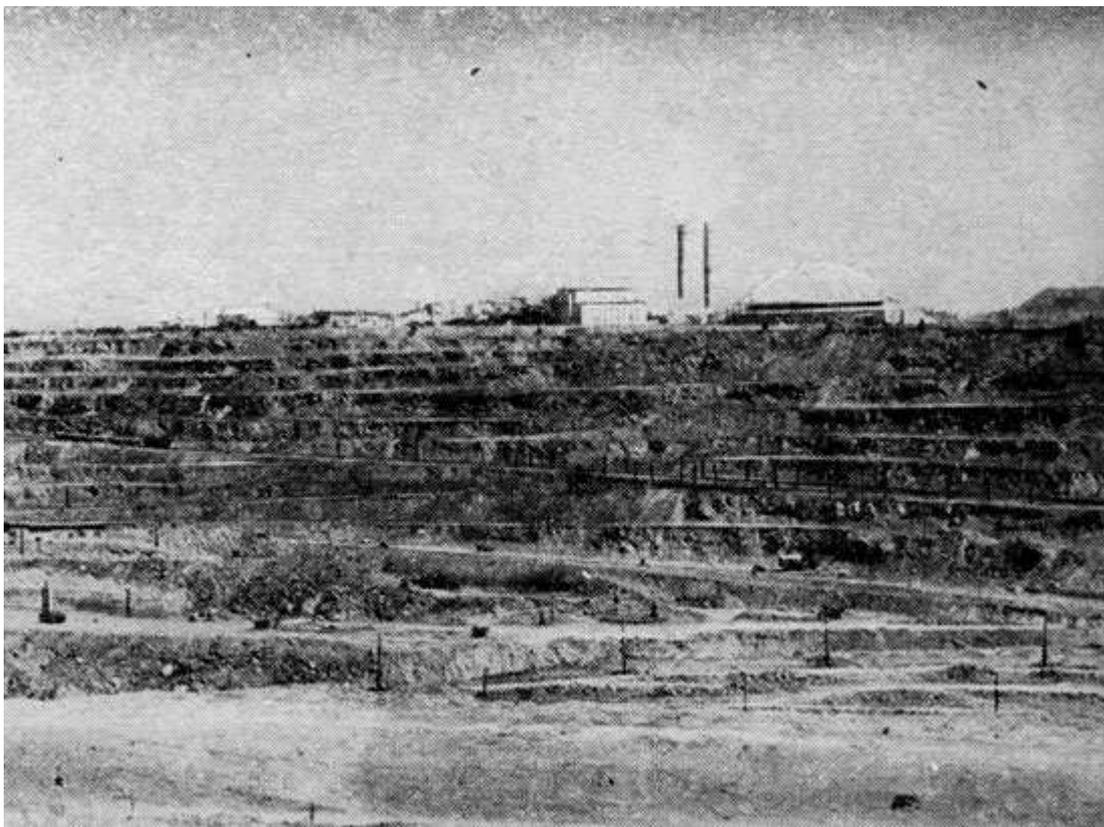
*Рис. 12. Вид части Главного Баженовского карьера в 1970 г. О масштабах карьера можно судить по размеру поездов и экскаваторов на противоположном склоне. Напомним, что в карьере ходят поезда широкой колеи с вагонами-самосвалами на 60-100 т*
