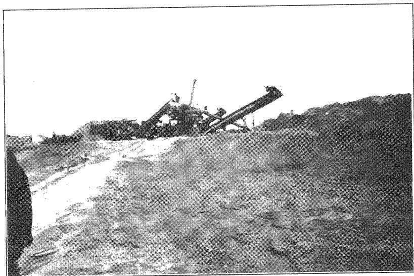
Рис.5.15. Укладка рудного штабеля на Бамском месторождении ООО ГРК «Апсакан»
