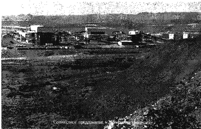
Рис.3.6. Совместное предприятие «Зарафшан-Ньюмонт», кучное выщелачивание забалансовых золотосодержащих руд
